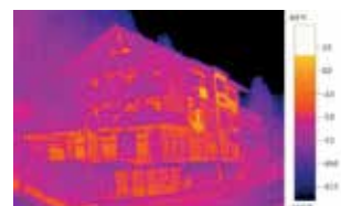
Imagen térmica con testo ScaleAssist
